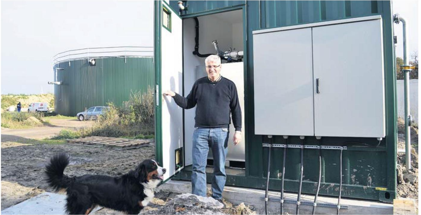
Landwirt Claus Luerßen auf seinem Aussiedlerhof am Ortsrand von Uthlede: Hier entsteht derzeit eine Biogasanlage. Mit dem Blockheizkraftwerk erzeugt Luerßen Strom und Wärme. Nun plant er ein zweites solches Blockheizkraftwerk auf seiner alten Hofstelle in Uthlede, Achterstraße. Damit könnten mehrere öffentliche Gebäude in der Umgebung mit Wärme versorgt werden. Foto us
